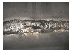
パイプ溶接部
